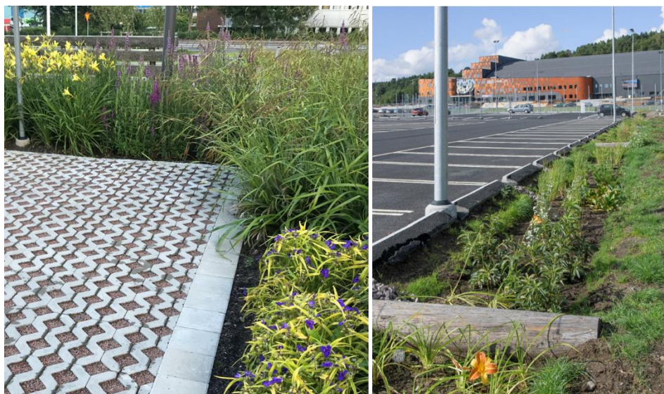
Figur 23. Grusarmering/hålsten på parkering och regnbädd intill parkering (Foton: t.h. Lina Ekholm, t.v. Peter Svensson).
